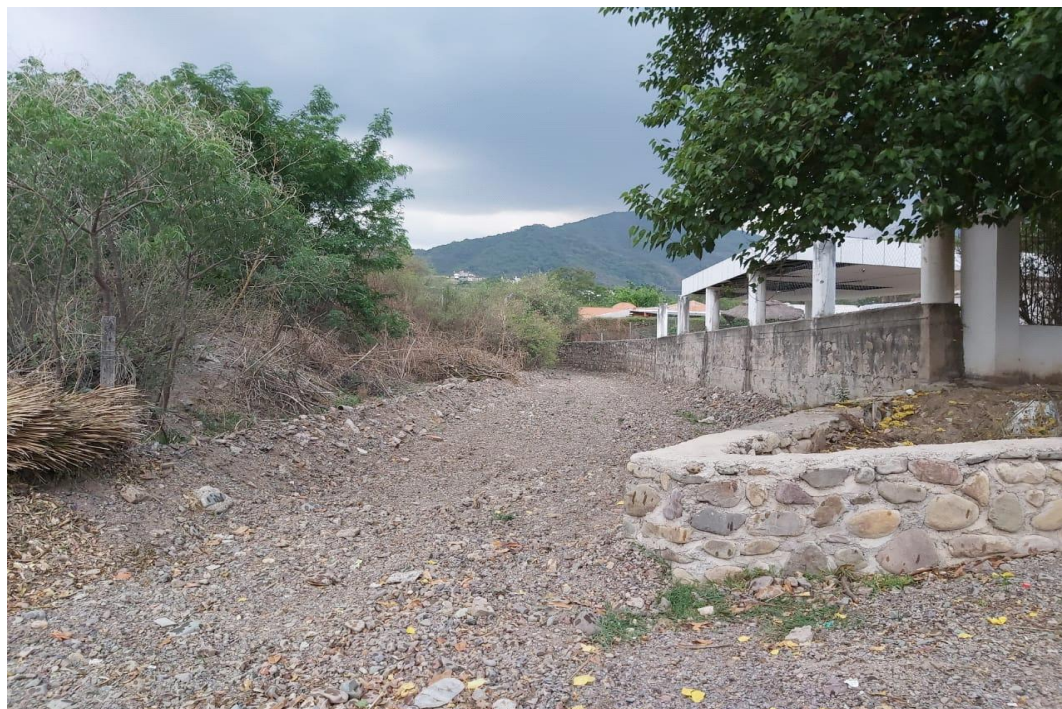
Ilustración 4 - Tramo del canal sin revestimiento
