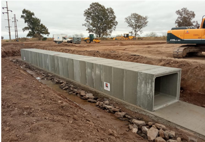
Ilustración 43 – Detalle de Módulo Pónico VIAL
