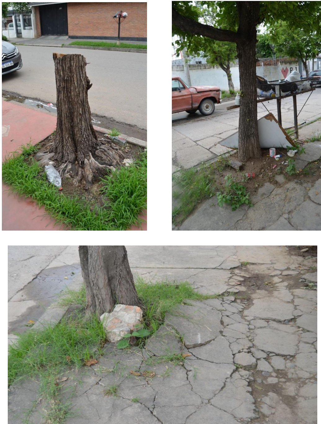
Figura 53. Sectores de cazuelas sobre veredas agrietadas con restos de residuos domiciliarios y de construcción.
