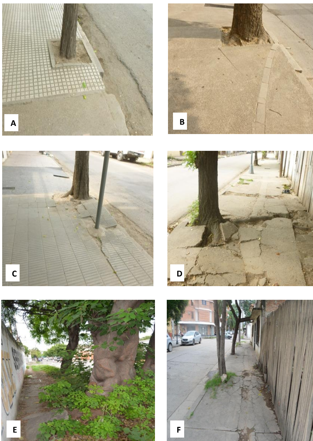
Figura 60. Tipos de daños en veredas. A. Vereda sin daño. B. Vereda con levantamiento de parte del cemento alisado (daño ligero). C. Vereda con daño moderado sin baldosas. D. Vereda con levantamiento y rotura del cemento (daño severo). E. Vereda intransitable por el levantamiento de las placas de hormigón debido al desarrollo del tronco y raíces de Broussonetia papyrifera (morera de papel). F. Vereda agrietada por la instalación de la red de gas natural.
