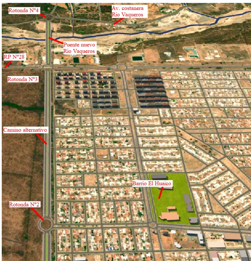
Ilustracion XXXV. Barrio El Huaico, Rotondas, RP N°28, costanera y puente Rio Vaqueros
