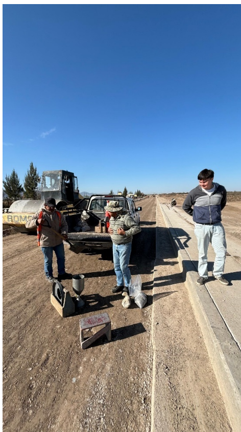
Ilustracion XLI. Ensayo VN - E8 – 66 Control de compactación por el método de la arena.
