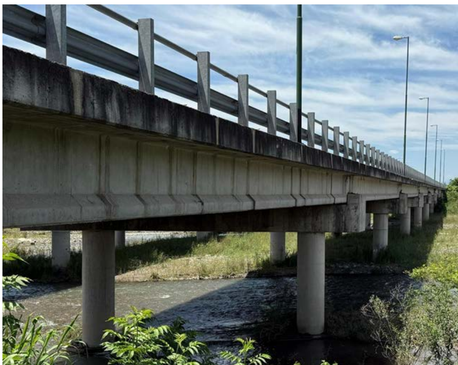
Ilustracion XXIX. Tope sísmico, viga dintel, columnas.
