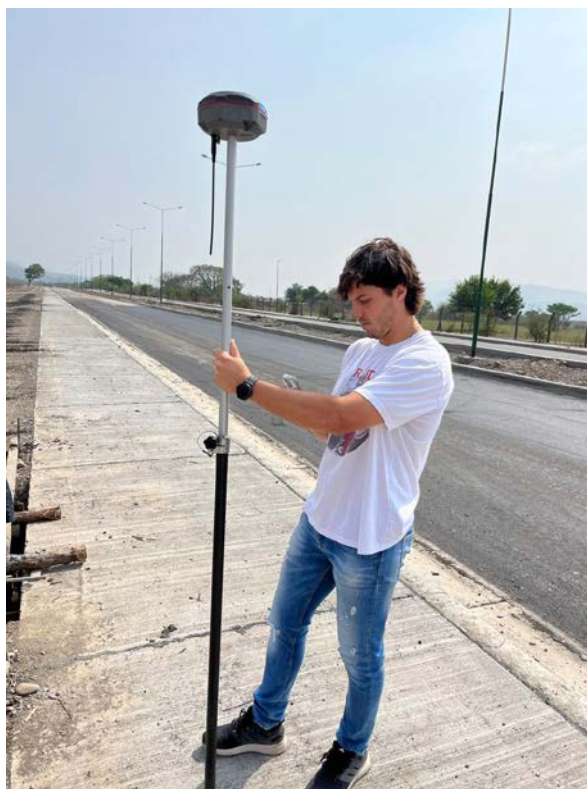
Ilustracion XLIII.Utilización del GPS en obra
