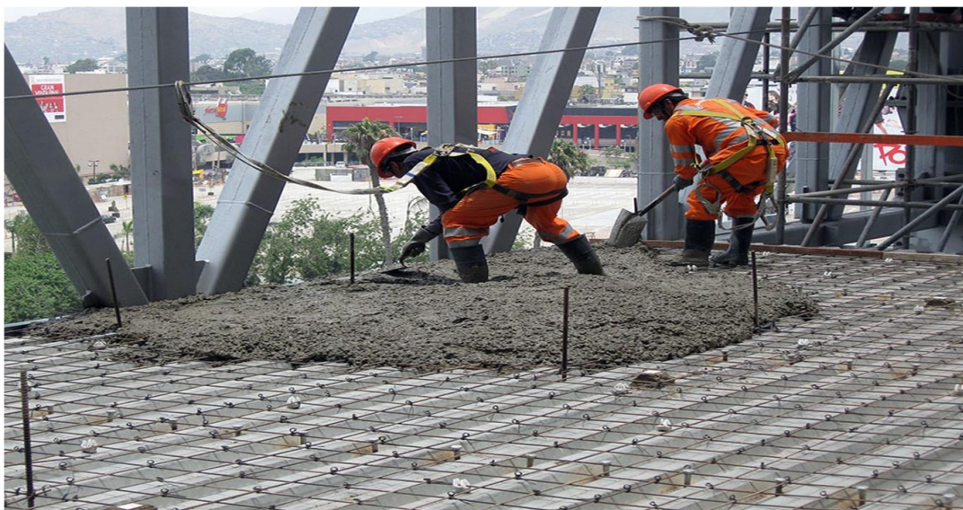
Ilustración 10: imagen ilustrativa del vertido de hormigón en losa Steel Deck
