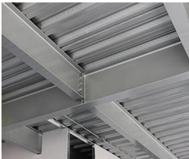
Ilustración 4: Imagen ilustrativa de perfiles metálicos y chapas de Steel Deck
