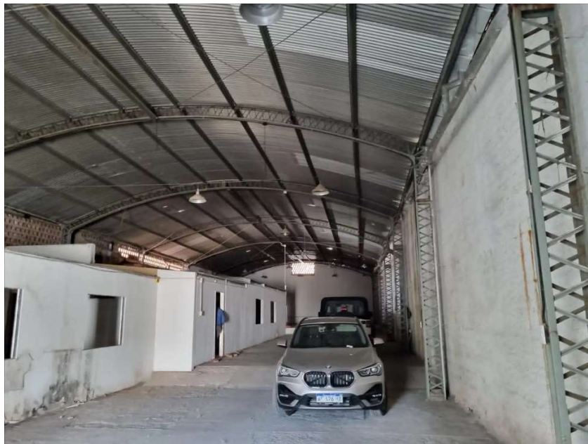
Ilustración 30 Vista interna de localización
